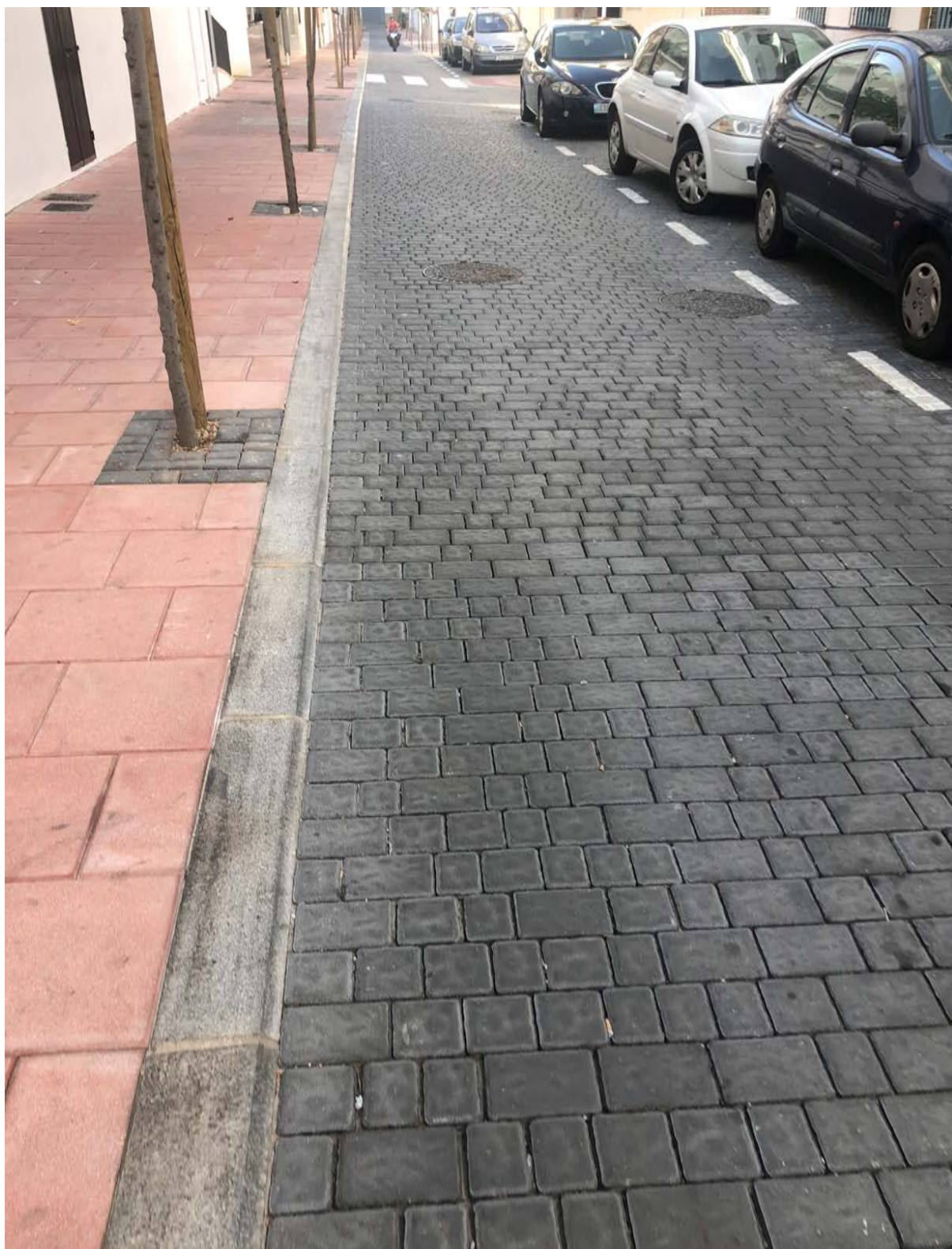
Vía rodada en Estepona
